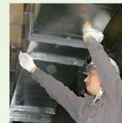
排気ダクト工事
